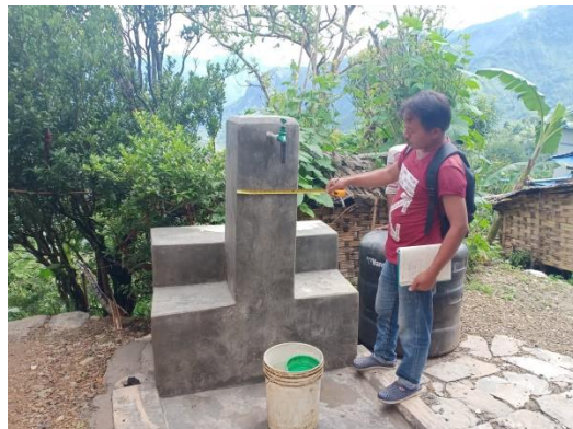
एक घर एक धारा कार्यक्रम अन्तर्गत वडा नं. ७ मा निर्माण गरिएको धाराको नमूना
